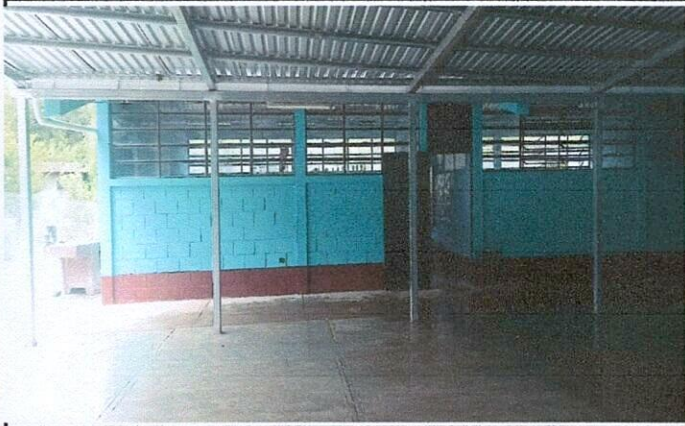
Foto 1: PROCESO DE MEJORAMIENTO DE TECHO DEL CENTRO EDUCATIVO.
