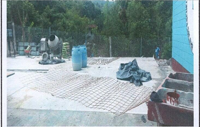
Foto 4: PROCESO DE LOZA DE PATIO DE ENTREDA CENTRO EDUCATIVO
